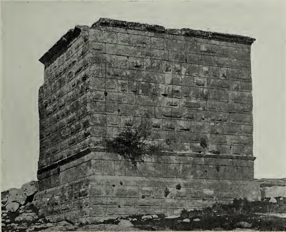
Fig. 27. — H. Qweismeh. Vue extérieure du mausolée; angle sud-ouest.
